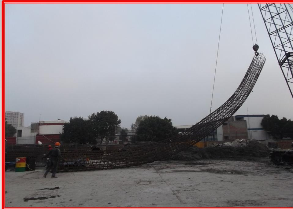
Izaje del primer tramo de tres, de 11 m de longitud del armado de la pila, para la cimentación de un edificio de departamentos en la Ciudad de México
