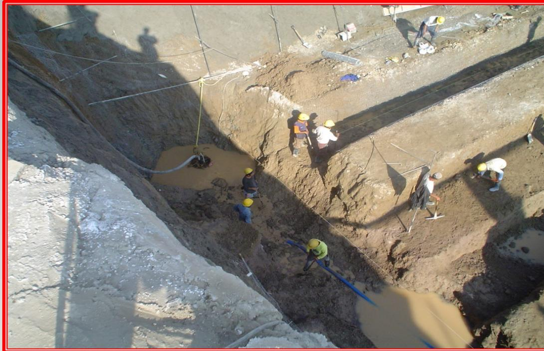
Abatimiento del NAF mediante un pozo de achique para la excavación del Deprimido en el cruce de las Avenidas de Paseo Toyocan con Colón en la Ciudad de Toluca, Edo. de México
