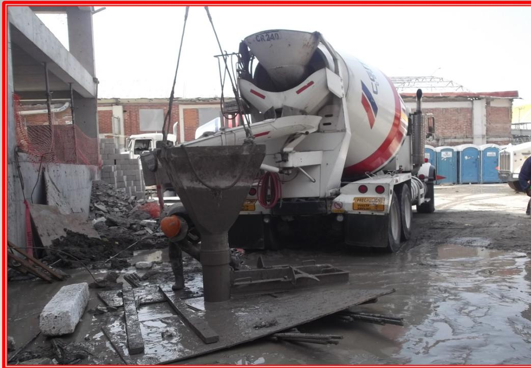
**Colocación del tubo "Tremie" para el colado con Concreto para la formación de la pila**
