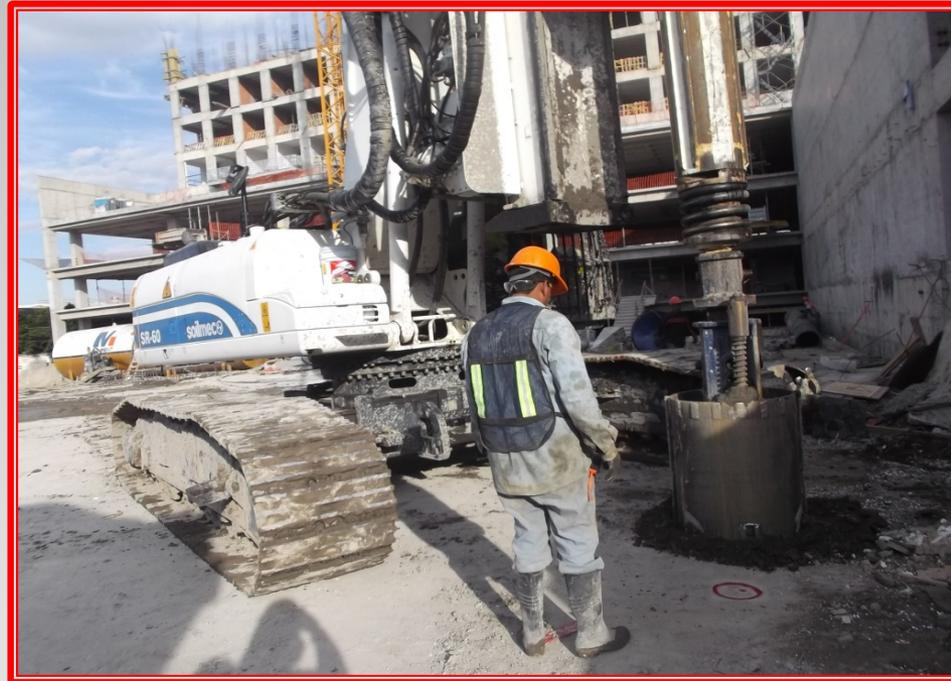
Barrenación previa con bote de 80 cm de diámetro para la instalación de una pila a 31 m de profundidad en suelo blando de la Ciudad de México
