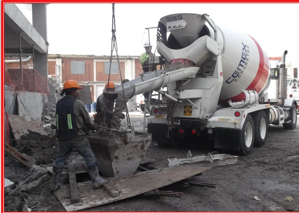
**Vaciado del concreto empleando "Tubo Tremie"
