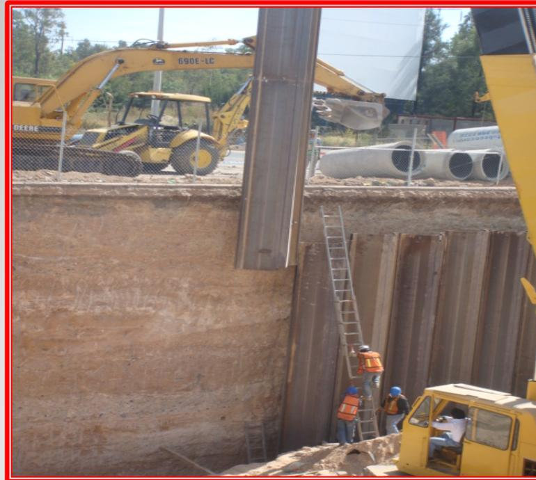
Colocación de tablestacas para estabilizar las paredes de la excavación a cielo abierto del Puente Guadalajara, ubicado sobre el Libramiento Norte a Tepic, en la Ciudad de Guadalajara, Jalisco
