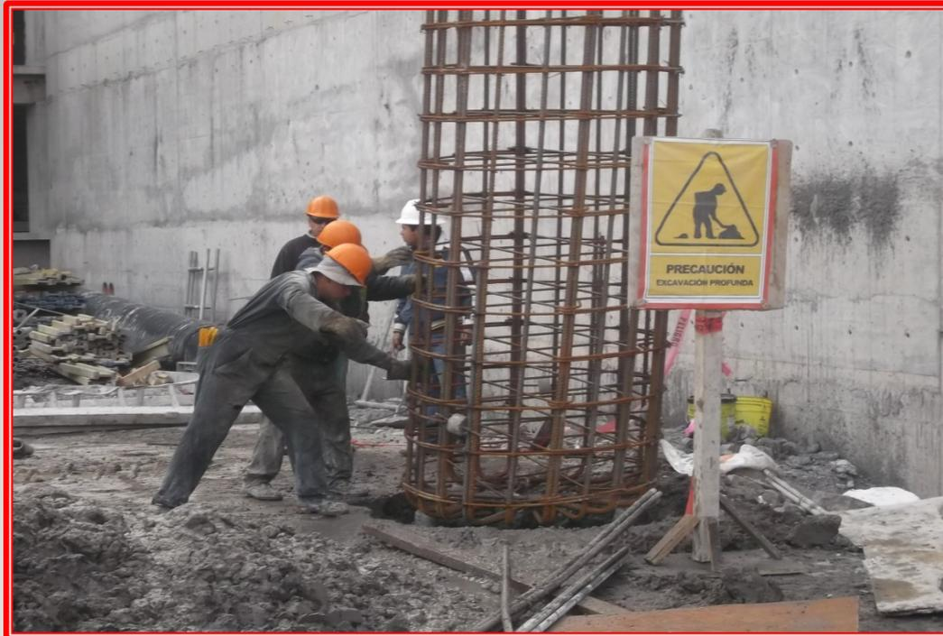
Trabajos de la colocación del armado de la pila
